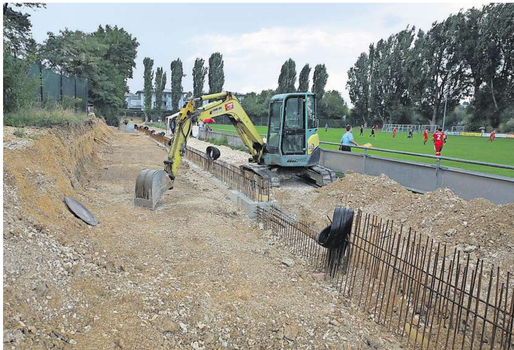
Die im Bau befindliche Hochwasserschutzmauer entlang des Fußballplatzes der SG Walhalla hat keine Auswirkungen auf den Spielbetrieb.
